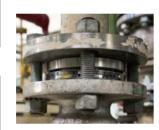
FTカタンクト部にラブチャーディスクと安全弁を直列に設 置した例です。この場合のラブチャーディスクは破裂時に破 この飛散がない型式が選定されます。
